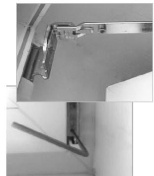
Если оконная створка с поворотно-откидным механизмом, то дополнительно можно отрегулировать прижим регулировочным винтом на ножницах рядом с верхней петлей.
