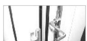
Производится при помощи эксцентриков (запорных цапф), расположенных по всему периметру окна.
